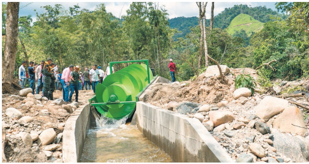
Instalación del hidrotornillo sobre un cañón del río Pato.
